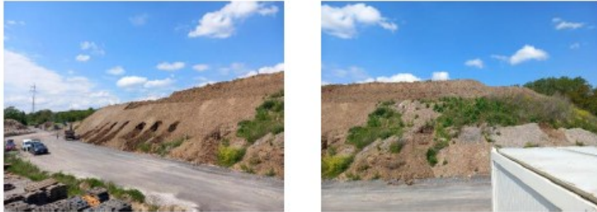
Fotos 1 und 2: Gesamthaufwerk (Südseite) mit Baggerschürfen (untere Reihe: Baggerschürfe BS 1 – BS 7)
