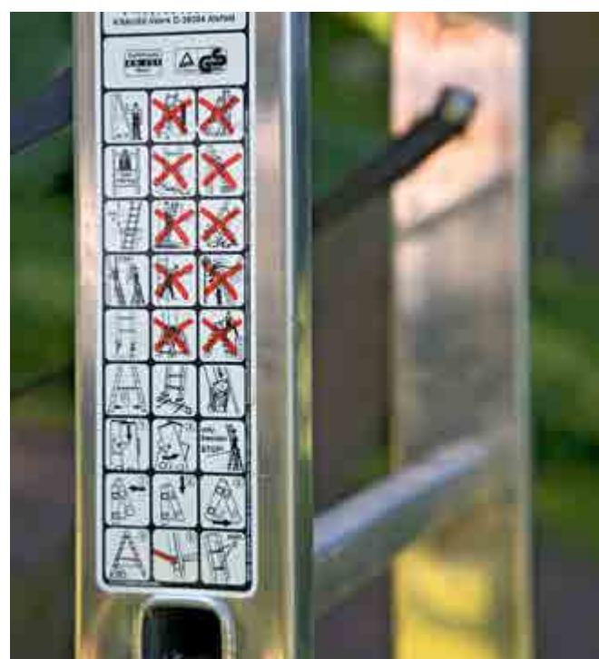
Abb. 130 Kurzbedienungsanleitung für Leitern
