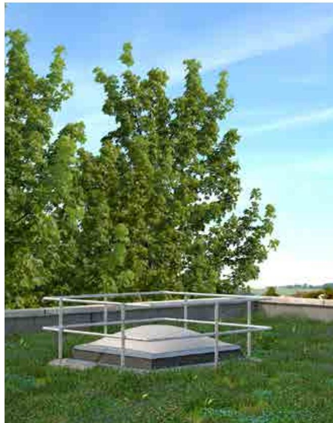
Abb. 134 Sicherung gegen Durchsturz
