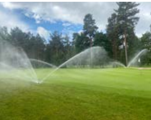
Die Überprüfung der Regner und Einstellungen: gerade bei älteren Anlagen zwingend erforderlich!
