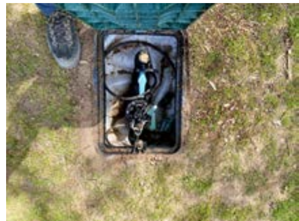
Erneuerung der Magnetventile und Ventilboxen
