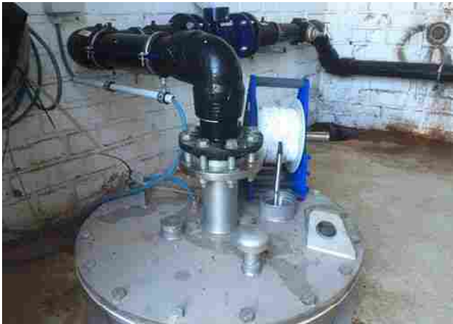
Abb. 4: Pegelmessung mittels Lichtlot über die Brunnenkopfföffnung
