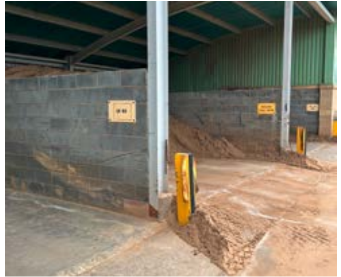
Der überdachte Sandlagerplatz auf dem Jubilee-Betriebshof.
