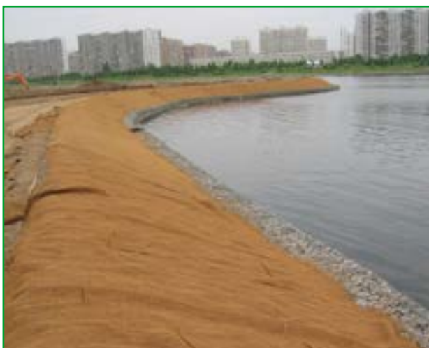
Verlegung von Erosionsschutzgeweben
