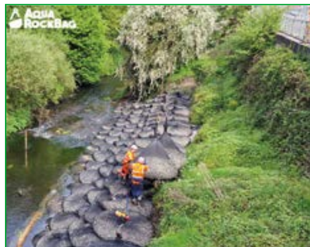
Verlegung von AquaRockBag®
