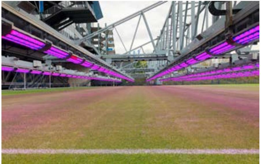
Abb. 1: Fußballarena mit LED-Rasenbelichtung.
