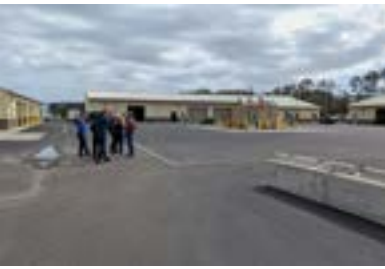
Der Betriebshof mit zentraler Tankstelle
