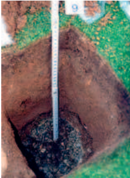
Foto 1: Wassereinstau aus der Dränschicht (Foto: Armbruster).
