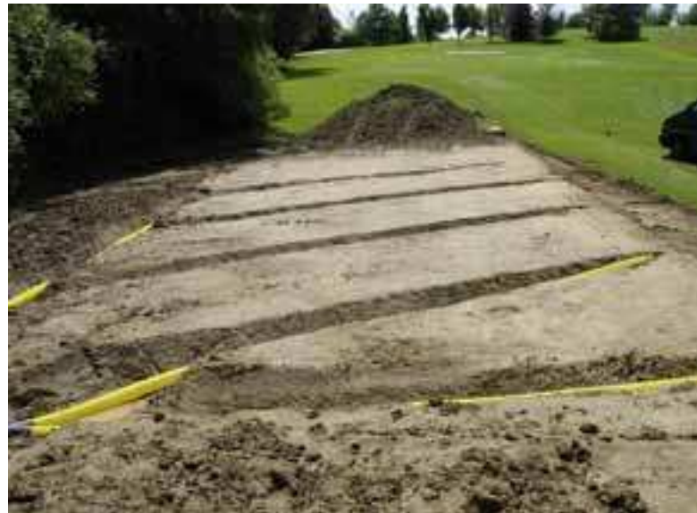
Drainagearbeiten auf der Anlage – natürlich in Eigenregie
