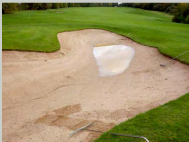
Abb. 2: Fehlende Funktionsfähigkeit der Dränage im Bunker
