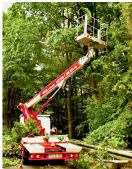
Abb. 14: ... gegebenenfalls kann auch der Einsatz eines Hubsteigers notwendig sein.
