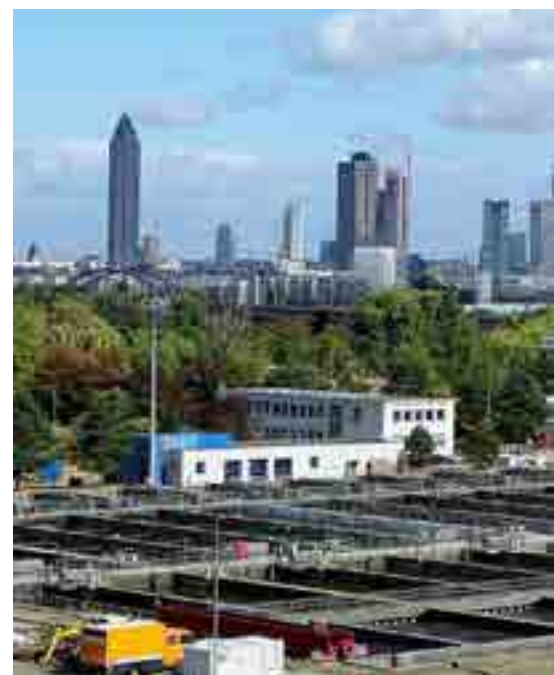
Abb. 4: Ablaufbecken der Kläranlage Frankfurt Niederrad.
