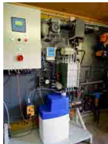
Abb. 2a+b: Greensaver-Anlage zur Behandlung des eingesetzten Brauchwassers.
