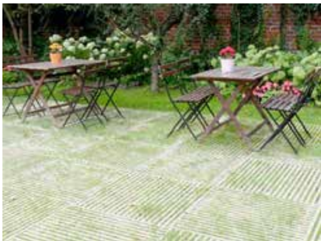
Abb. 7: Rasenplatten (Schweizer Patent) im Mönchgarten (Havelberg).
