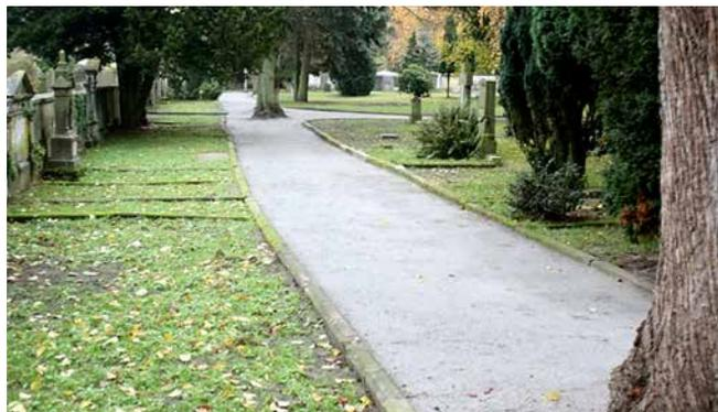
Abb. 4: Die verdichtete Deckschicht.
