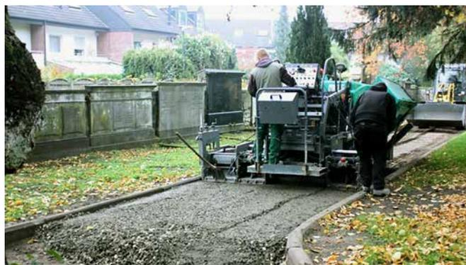
Abb. 3: Einbau der Tragschicht mit dem Fertiger.
