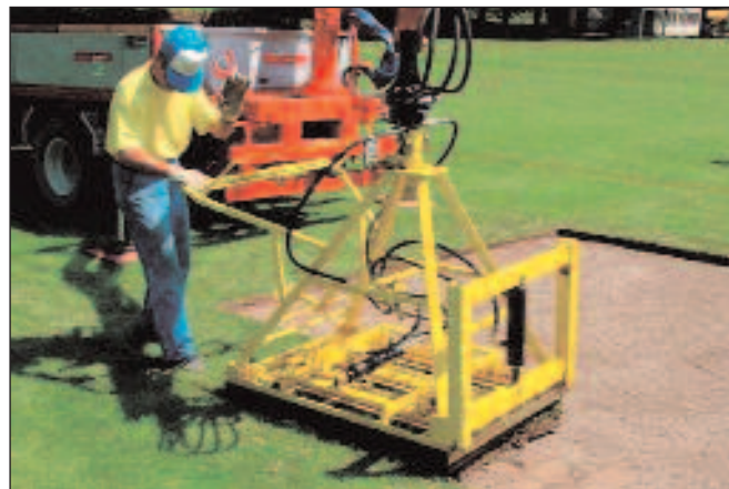
Verlegen der Rasenplatten
