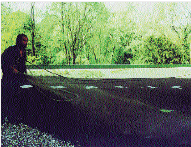
Abb. 1: Auftragen der Nähr- und Wachstumsschicht unter hohem Druck und spitzem Anspritzwinkel
