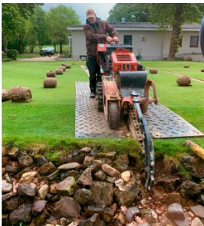
Eine der in der Folge durchgeführten Maßnahmen: am Clubhaus wurden auf dem Übungsbereich die Drainagen verbessert.
