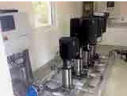
**Abb. 2: Frequenzgesteuerte Pumpen- bzw. Druckerhöhungsanlage**
