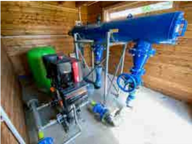
Abb. 4: Pumpenanlage mit Siebfilter
