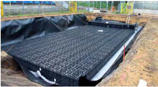
Der Blockverbund überzeugt trotz einer geringen Überdeckung von 1,32 m mit einer Befahrbarkeit nach SLW 40.
