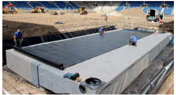
Die innere Schicht wurde in einem zweiten Arbeitsschritt mit einer wasserundurchlässigen 2-mm-HDPE- Kunststoffdichtungsbahn verschweißt.
