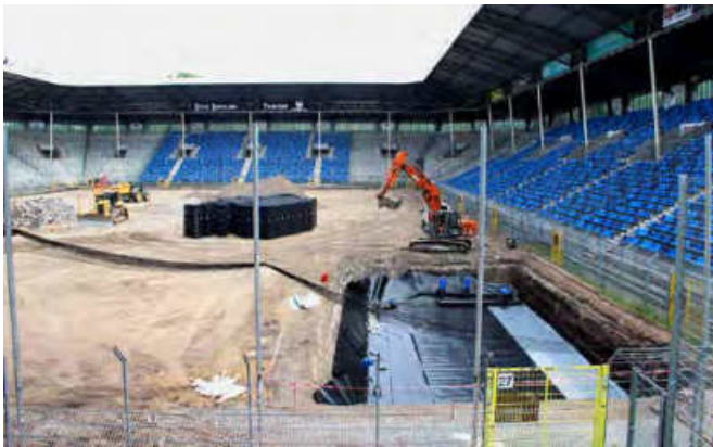
Die Einbausohle für die Regenwassernutzungsanlage wurde in einer Tiefe von 2,64 m unter Geländeoberkante vorbereitet. (Alle Fotos, soweit nicht anders gekennzeichnet: GRAF)
