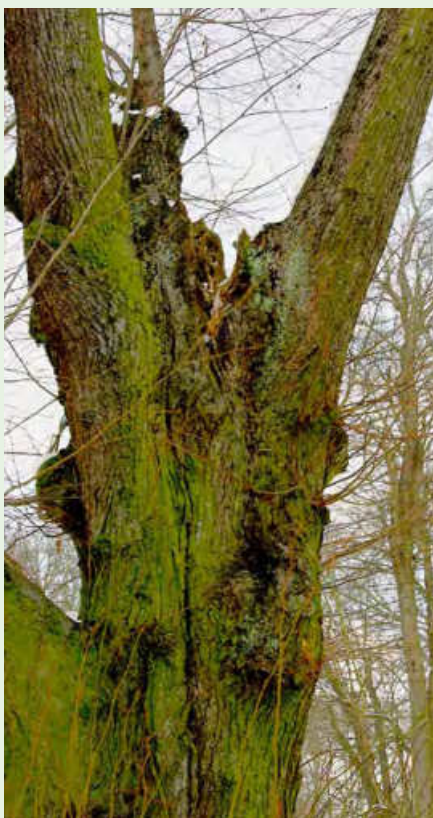
Abb. 14: Dieser V-Zwiesel ist bereits eingegrissen und droht auseinanderzubrechen, es besteht Bruchgefahr.
