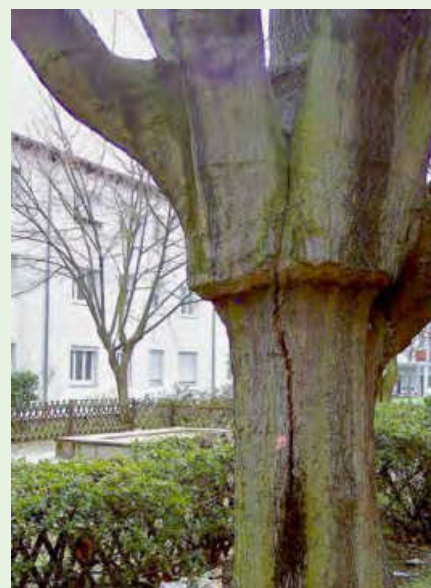
Abb. 10: Alte Pfropfstelle, auch hier ist die Silber-Linde deutlich über den Umfang der Unterlage hinausgewachsen. Zudem hat sich ein Riss von der Unterlage nach oben gebildet; hier besteht Handlungsbedarf.
