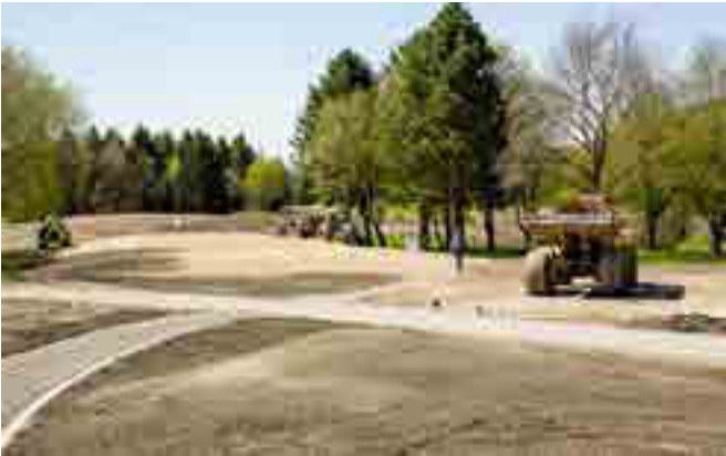
Der Neubau des West Courses steht kurz vor seinem Abschluss. Die Breaks sind fertig ausgestaltet und die Infinity-Regner sind eingebaut.
