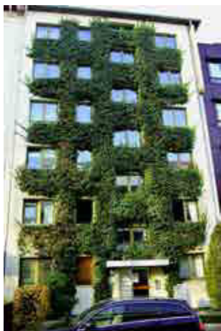
Abb. 1: Der Efeu kann Hausfassaden völlig bedecken; er ist unter anderem ökologisch bedeutsam, als Lebensraum für Vögel und Insekten.
