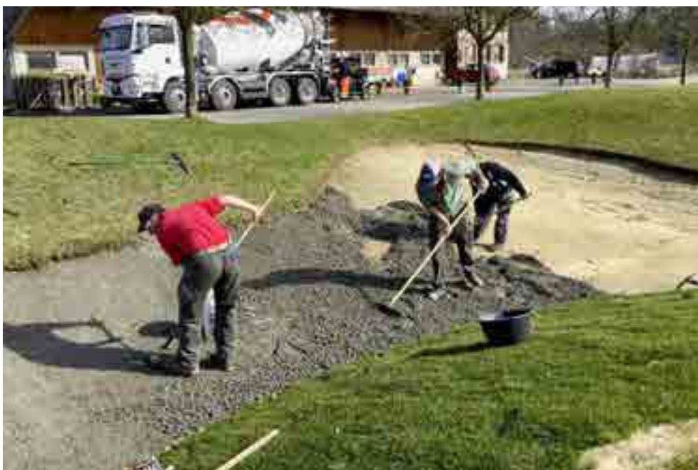
Nach Leerung des Bunkers und Prüfung der Drainage wird Capillary Concrete in einer gleichmäßigen Schichtdicke von 5 cm aufgebracht – z.B. durch das eigene Greenkeeping-Team.
