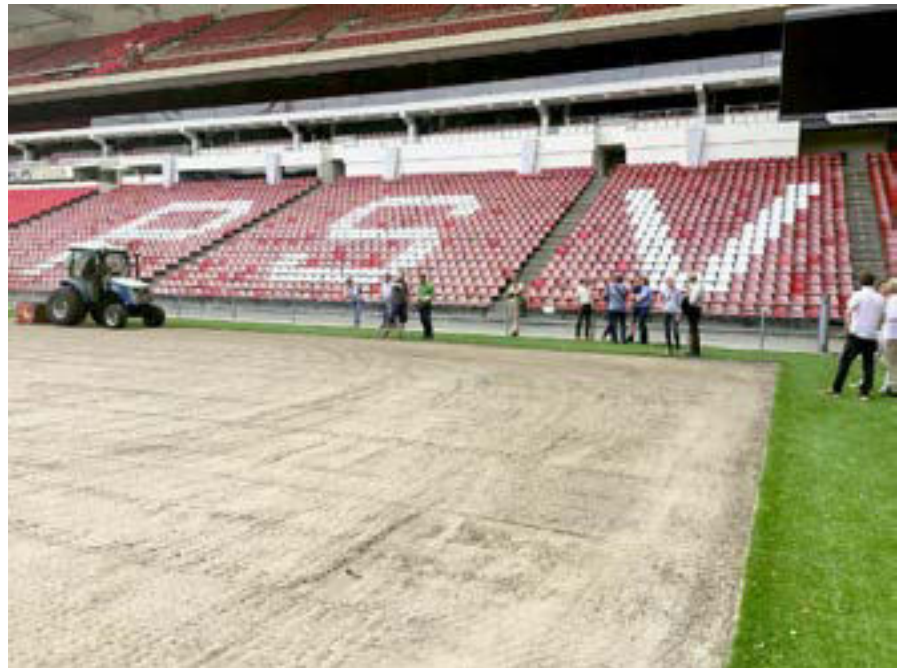
Abb. 2: Bearbeitung der Hybrid-Rasentragschicht im PSV Stadion Eindhoven, NL. (Foto: P. Baader)
