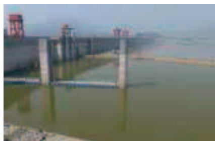
Abb. 3: Noch bleiben 30 Meter Fassungsvermögen bei der 185 Meter hohen und 2,34 km langen Staumauer, die an der Basis 130 und an der Krone 18 Meter Stärke aufweist.
