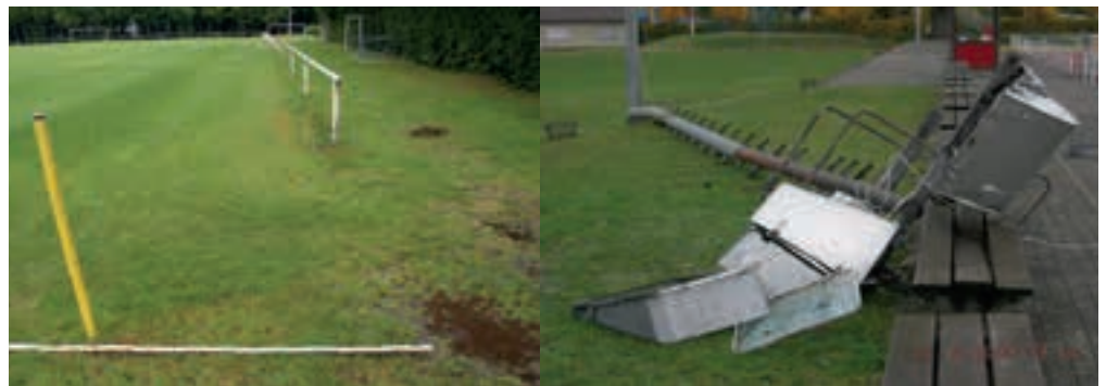
Abb. 4: links: Unzureichende Sicherheitsabstände können zu Verletzungen führen, für die unter Umständen der Betreiber verantwortlich gemacht werden kann. Rechts: Nächtlicher Mastumbruch. Schadenstelle: erster Absatz auf ca. 4 m Höhe System: Stahlmast verzinkt, abgesetzt, ca. 30 Jahre alt, Lichtpunkthöhe: 18,50 m. (Foto: Roch, Lübeck)
