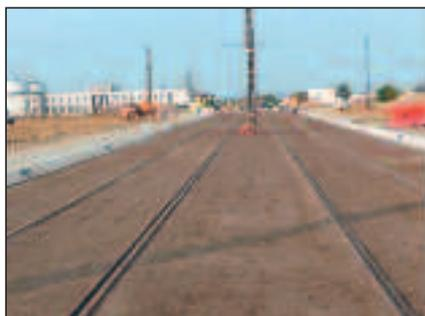
Abb. 8: Vorbereitung des Gleiskörpers mit Rasentragschicht zur Begrünung der neuen Tramway in Angers mit 56.000 m<sup>2</sup> Fertiggras.
