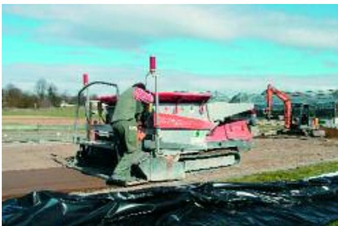
Abb. 1: Einbau einer neuen Rasentragschicht auf der Hohenheimer Lysimeteranlage mit Fertiger
