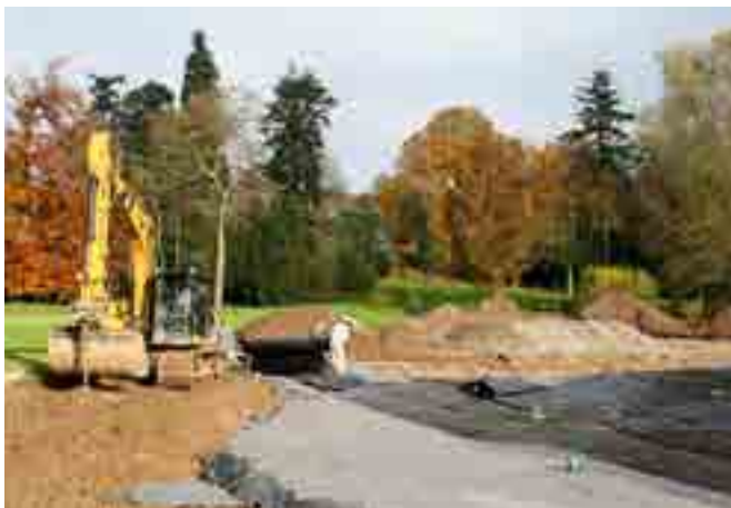
Folienverlegung beim Teichneubau
