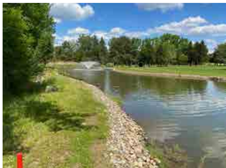
Teichrandgestaltung mit Wasserbausteinen im Wasserwechselbereich (Alle Fotos: A. Klapproth)
