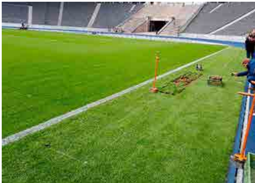
Abb. 1: Rasensodenstecher im Gebrauch, einzelne Rasensoden werden am Spielfeldrand ausgestochen und im Spielfeld zum Ausbessern von Schäden wieder eingesetzt.
