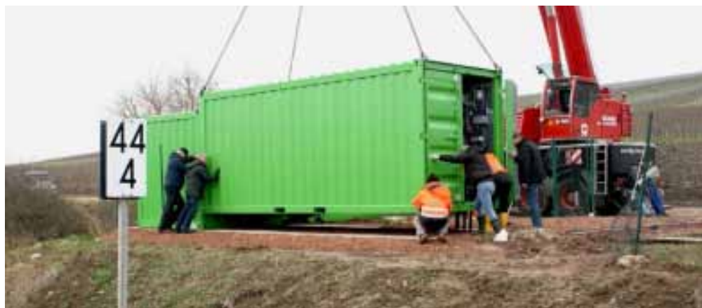
Aufstellen der Containeranlage.
