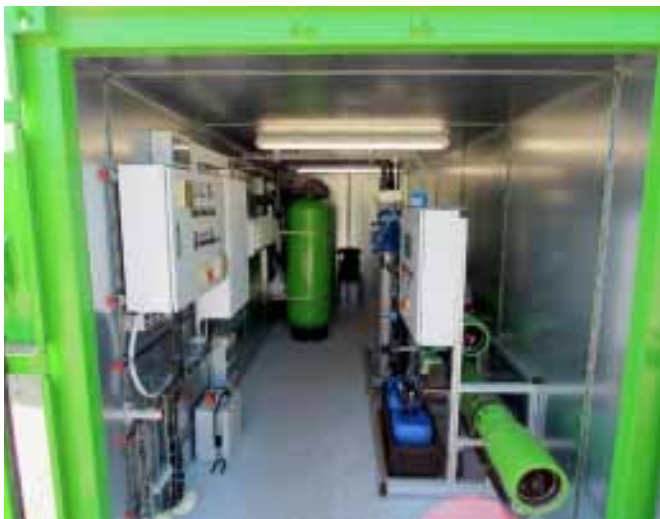
Innenansicht Container mit Umkehrosmoseanlage.
