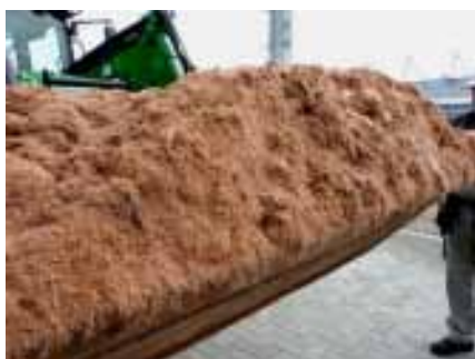
Abb. 7: Fertig gemischtes, armiertes RTS-Material (Fibrelastic) für den Einbau eines Trainingsplatzes. (Foto: K.G. Müller-Beck)
