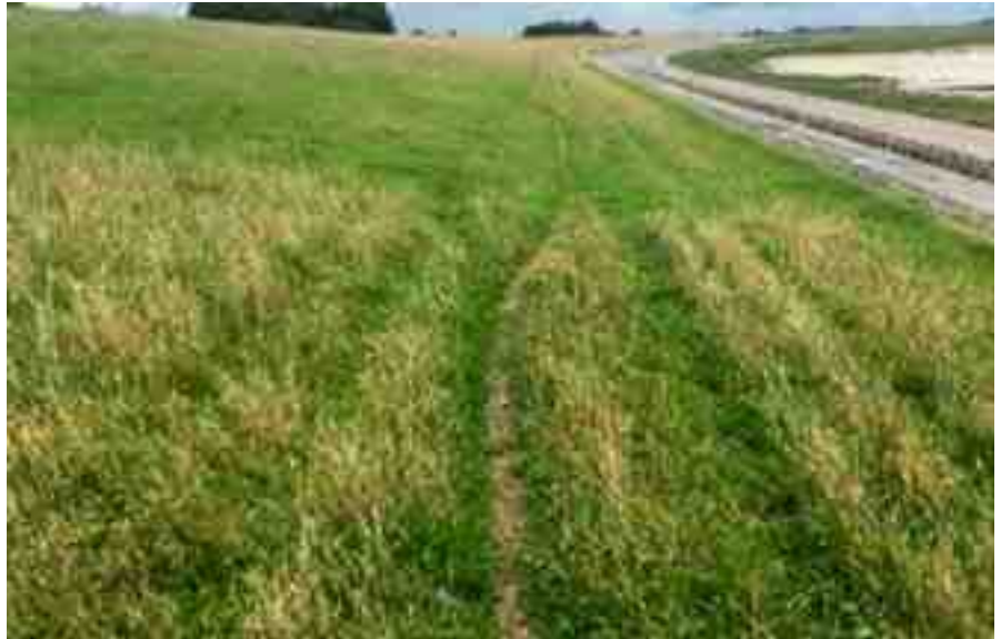
Foto 1: Deichböschung wasserseits mit Trampelfaden Richtung Süd-Osten.
