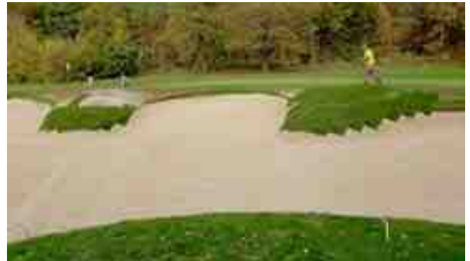
Abb. 3: Besodung der Bunkerzungen
