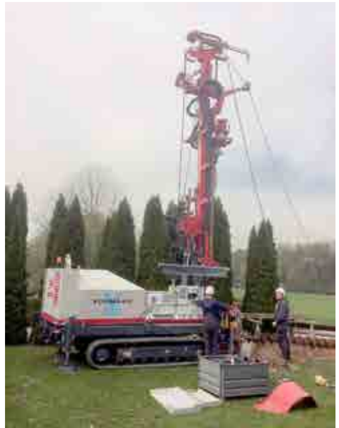
Abb. 1: Die Brunnenbohrung erfolgt mittels Spezialgeräten. (Alle Fotos: A. Klapproth)
