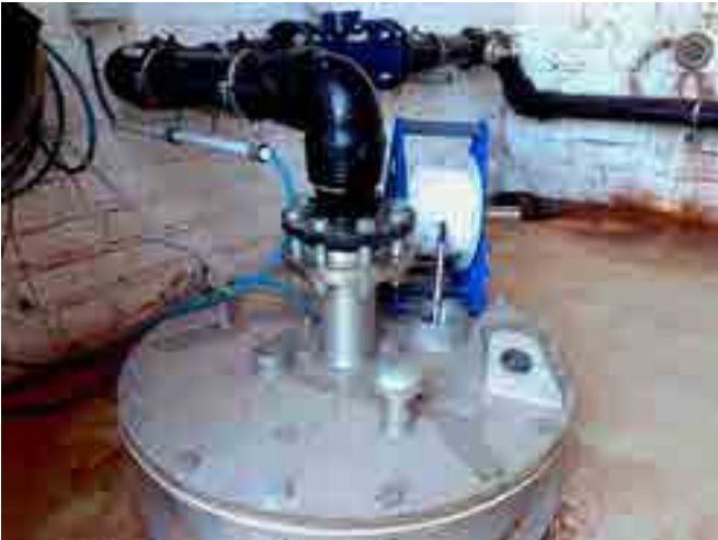
Abb. 5: Pegelmessung mittels Lichtlot über die Brunnenkopfföpfung
