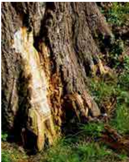
Abb. 1: Rindenschäden am unteren Stamm bieten ideale Eintrittspforten für Sporen holzerstörender Pilze. (Alle Fotos, soweit nicht anders angegeben: I. Hagemann)
