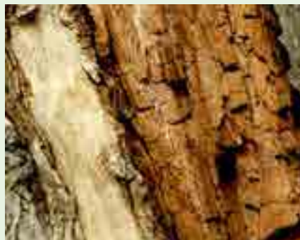
Abb. 14: Braunfaules Holz ist deutlich an der Farbe und den würfelartigen Bruchflächen zu erkennen.
