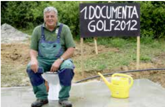
Werner Weybrecht „dokumentiert“ den Baubeginn zweier massiver WC-Häuschen und nimmt schon mal Platz.
