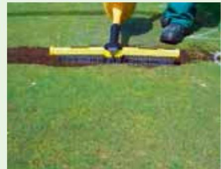
Abb. 4: Ausbringen der BIOCRACK®-Emulsion.
