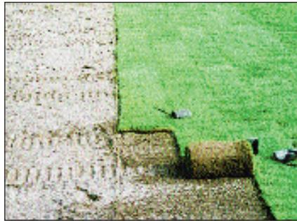
Abb. 3: Verlegung eines Sportplatzes mit Standardrollen
