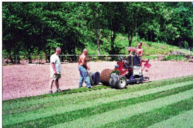
Abb. 2: Maschinelle Verlegung der 60er Rolle
