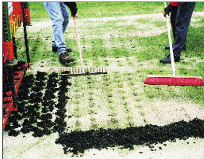
gang bis zu 40 cm tief und erreichte dabei eine Flächenleistung von 1,5 qm bzw. ca. 80 qm in der Stunde. Dann begann die äußerst intensive Handarbeit. Das herausgebohrte Erdmaterial wurde mit der Schaufel aufgeladen und weggefahren. Leider wurden dabei die 28 mm Durchmesser großen Löcher zugeschnitten, weshalb jedes Loch wieder mit ca. 20 mm dicken Rundstäben geöffnet werden musste.
