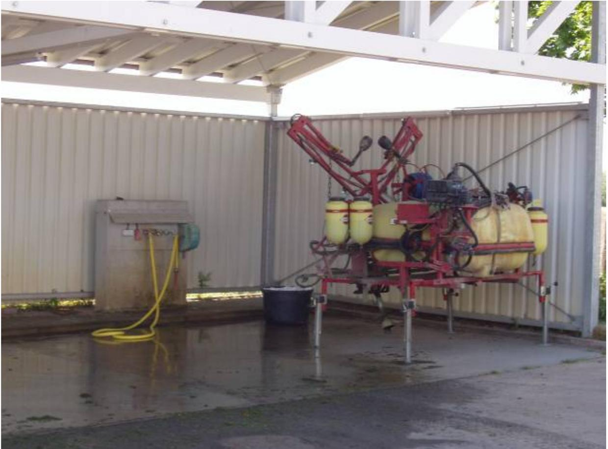
Überdachte Befüllstation mit Zisterne zum Auffangen von Pflanzenschutzmittelresten
