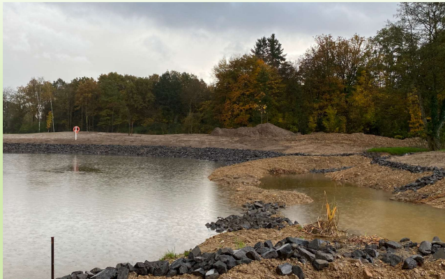
Rückhaltebecken ca. 10.000 m 3 mit naturnaher Einleitung
