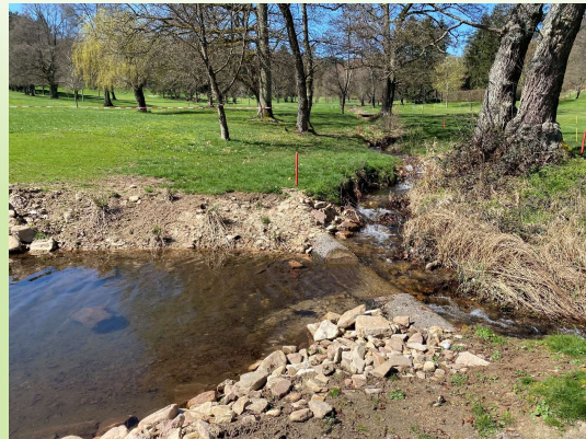
Streichwehr aus einem Baumstamm ist geregelt, das eine Mindestwassermenge von 1,5 l/s durchfließen kann.
