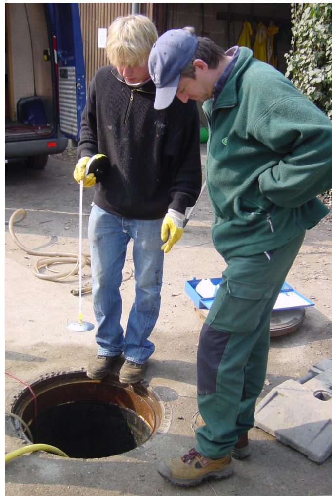
Dichtigkeitsprüfung und Schlammstärkenmessung im Rahmen der Einweisung zur Eigenkontrolle. (Foto: A. Klapproth)
